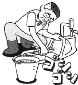
※排水線には水垢がつきやすい。溜まり水を除去することによって、排水線がはっきり見える。
